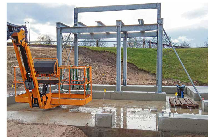
Ein Meilenstein 2025 – ein neuer Rechen und Sandfang auf der Kläranlage Lübbtheen. Auch 2026 haben WBV und AZV viel vor. Foto: WBV
