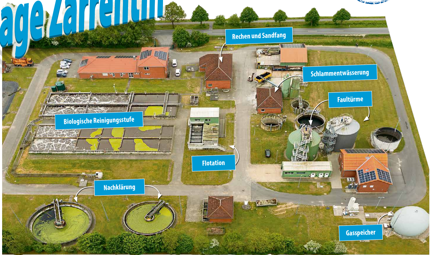
Erkenntnis heute: Es war gut, auf der grünen Wiese außerhalb von Zarrentin und weg vom Schaalsee so viel Platz zu haben, dass Erweiterungen problemlos möglich waren.
