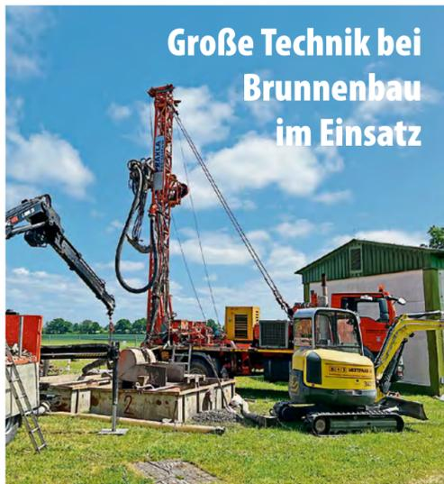
Ende Mai gingen die Bohrarbeiten für den neuen Brunnen in Setzin los. Große Technik ist dafür nötig. Immerhin geht es bis zu 50 Meter in die Tiefe. Brunnenstube, Rohrbau und Elektrik müssen nun noch folgen, dass der Neue Ende des Jahres den Vorgänger aus den 1970er-Jahren ablösen kann. Foto: ZV
